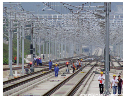
Die Hochgeschwindigkeitsstrecke Guangzhou-Shenzhen-Hong Kong im Bau (Mai 2011).
