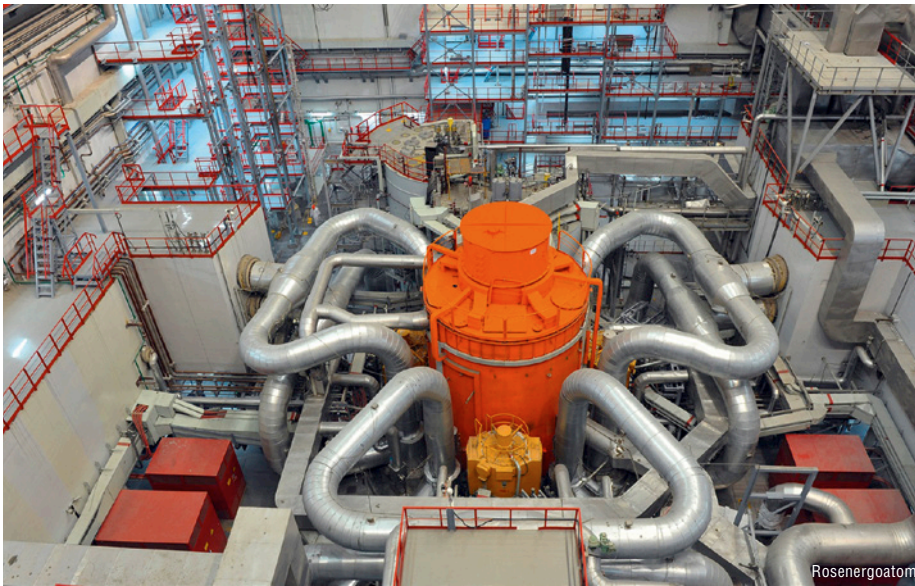
Abbildung 3. Blick in den Reaktorkern des BN-800.
